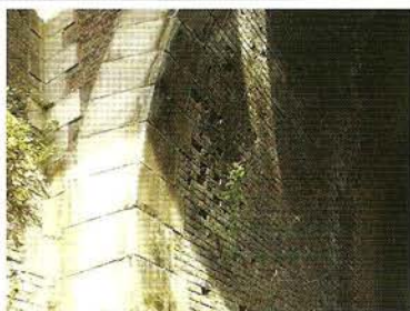
Ouvrage d'art, rues Eloi Morel et Abbé de l'Epée sous le bd Beauvillé
