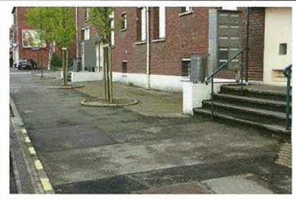
les trottoirs vont être bientôt refaits après les travaux
