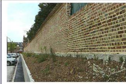
la rénovation du mur depuis la dernière visite de proximité
